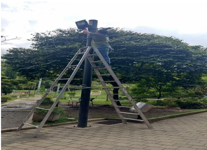
Ilustración N°9 Escaleras actuales (no cumplen con la norma de seguridad)
